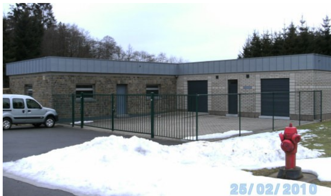
Trinkwasseraufbereitungsanlage im Rodter Venn
